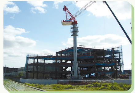
新病院建設中（北側から）
