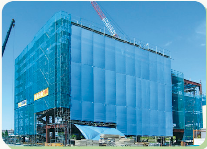
新病院建築中（南西から）
